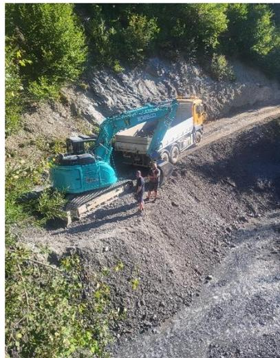
Entleerung der Auffang-/Rückhaltebecken
